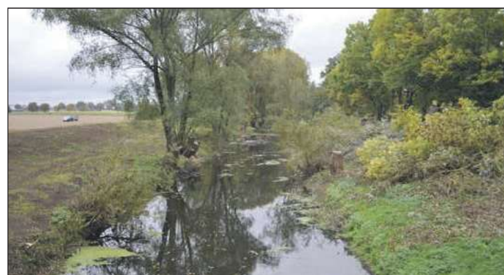
Der Hochwasserschutz an der Glenne wird seit vielen Jahren mehr oder weniger heftig diskutiert.
