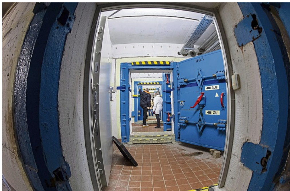
Der Blick in eine andere Welt: Fünf dicke Stahltüren bilden die Schleuse am Eingang zu einem DDR-Bunker in Mecklenburg-Vorpommern. STEFAN SAUER/DPA
