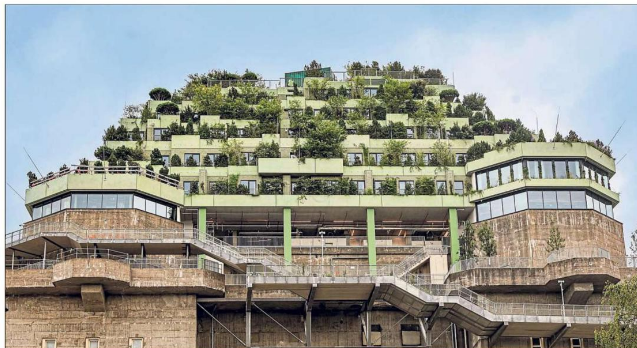
Der sogenannte „Grüne Bunker“ im Hamburger Stadtteil St. Pauli hat seit langem keine Schutzfunktion für die Bevölkerung mehr. In den vergangenen Jahren wurde der einst 38 Meter hohe Flakbunker auf 58 Meter erhöht und mit viel Grün bepflanzt. Ein 550 Meter langer Pfad führt bis auf das Dach zu einem 1400 Quadratmeter großen öffentlich zugänglichen Stadtgarten. Ein Hotel, Restaurants und Cafés locken Touristen an. Foto: dpa
