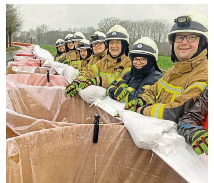
Trotz Weihnachts-Einsatz gute Laune: Wehrlaute kontrollieren den Hochwasserschutz an der Glenne.
