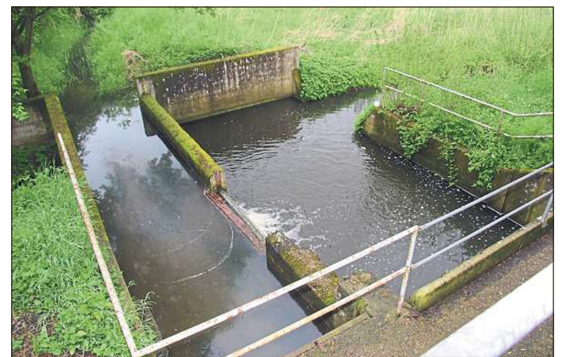
Erreicht das Wasser in den Vorflutgräben eine bestimmte Höhe, wird es in die Glenne abgepumpt. Laut Zin 19 ein System, das sich bewährt hat.
