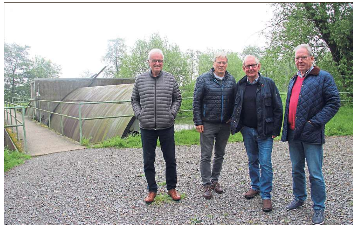
Eine Denkmal-Unterschutzstellung für das Poldergebiet an der unteren Glenne mit dem dazugehörigen Pump- und Schöpfwerk wollte die Gruppe Zin 19 Wadersloh mit (v. l.) Paul Plümpe, Wolfgang Kießler, Richard Streffing und Günther Petermeier erreichen. Ihr Antrag wurde abgelehnt. Die Art und Weise sowie die Begründung stößt der Initiative sauer auf. Fotos: Lange
