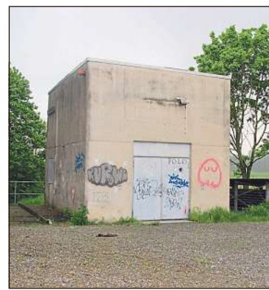
Aus den 1960er-Jahren stammt die Anlage im Poldergebiet.
