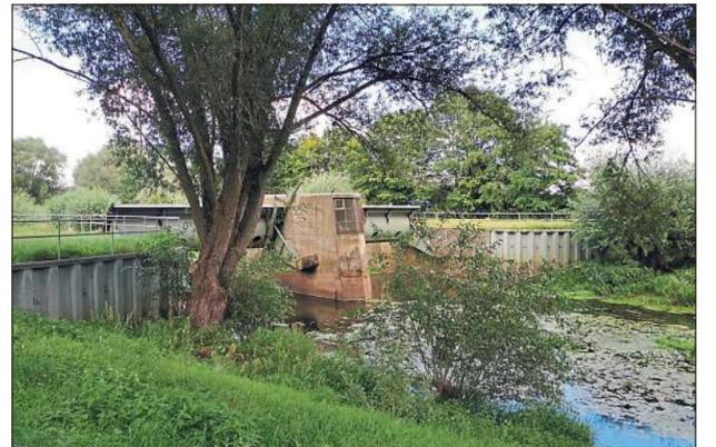
Das alte Pumpwerk an der Glenne soll nach den Plänen abgebaut werden. Stattdessen sollen fünf dezentrale Pumpwerke die Oberflächenentwässerung gewährleisten, schreibt der Kreis Soest zu dem Thema.
